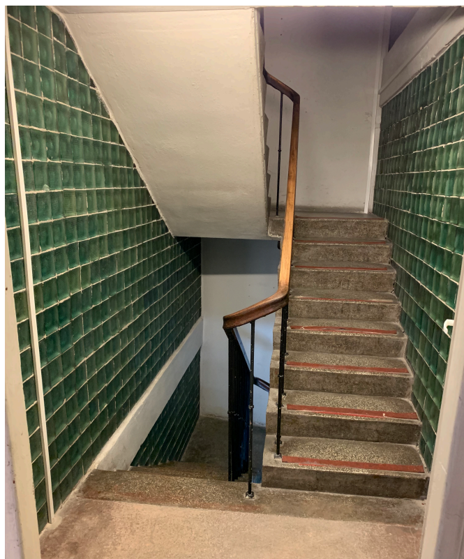
Zdjęcie nr 4 Widok klatki schodowej nr K1 z powierzchniami wypełnionymi cegłą szklaną
